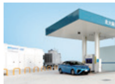
北大阪水素ステーション
